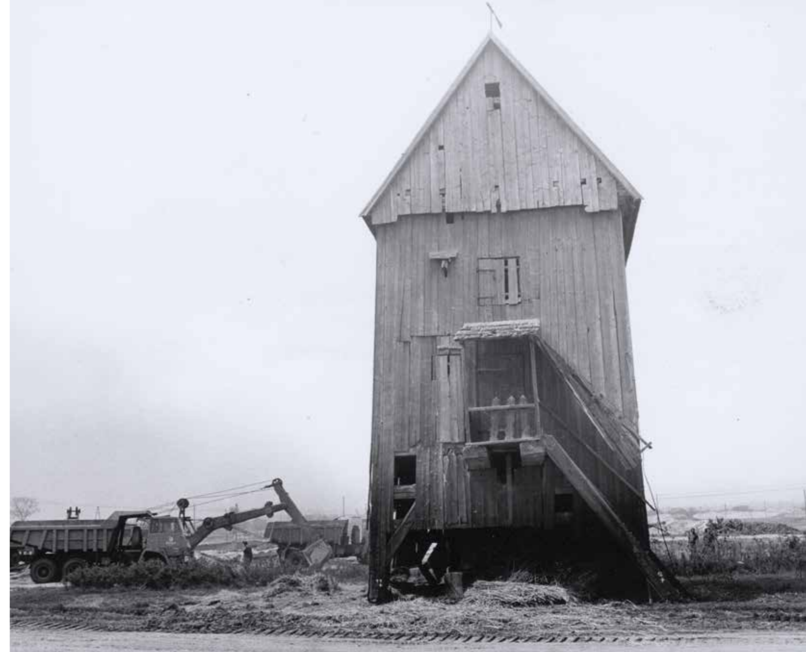
Początek prac przy budowie ZACH Metalchem, 1975 r., zbiory: MŚO
