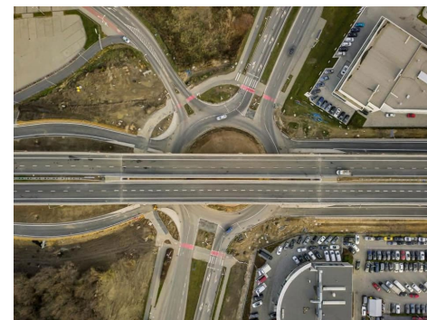
Budowa Obwodnicy Piaśtowskiej
