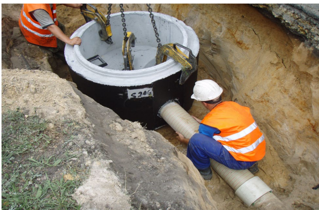
Poprawa jakości wody w Opolu (projekt ISPA z innymi gminami) Dofinansowanie: 165 mln zł
