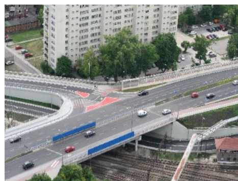
Budowa wiaduktu w ciągu ul. Ozimskiej nad linią PKP
