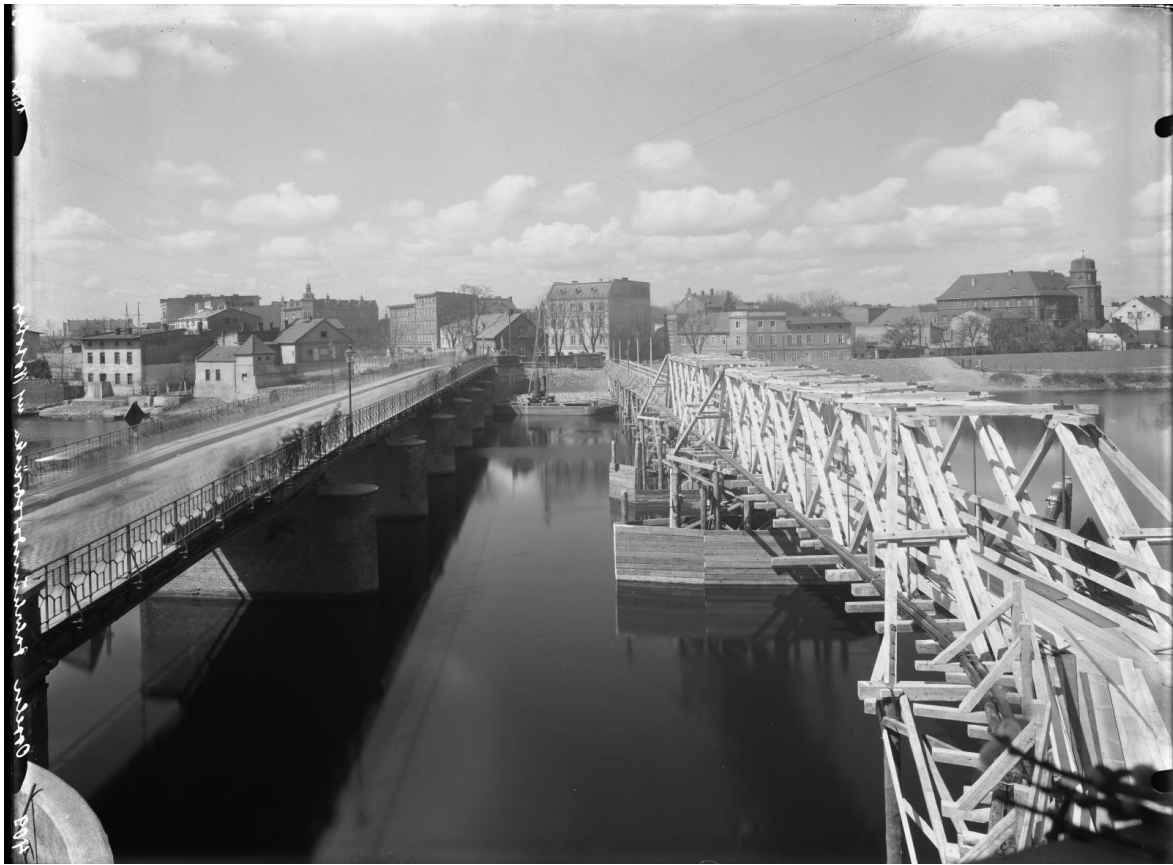
Most Stulecia w trakcie kapitalnego remontu, ok. 1932 r. - widok w stronę Zaodrza
