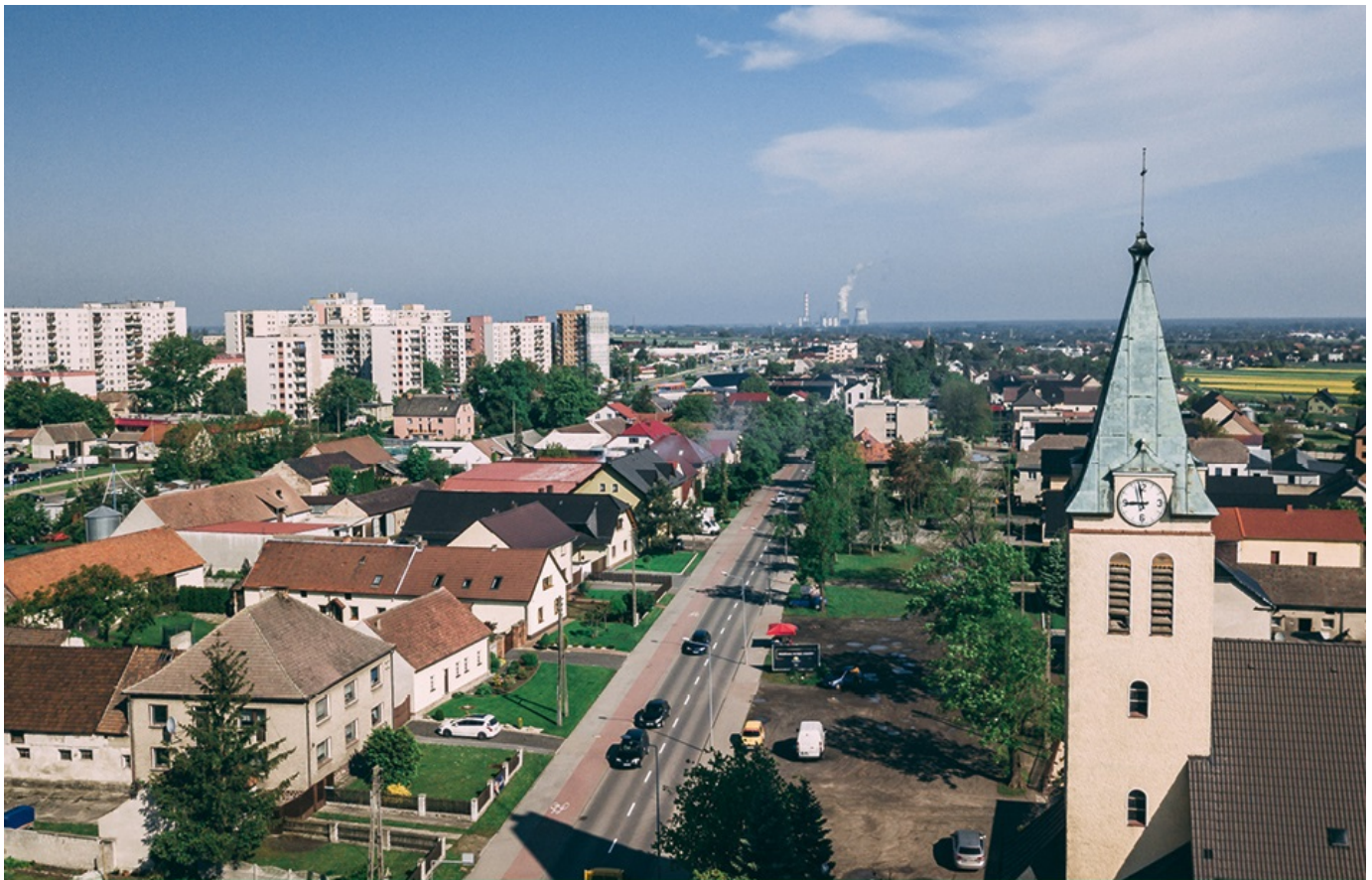
Widok na ul. Wiejską przecinającą Gosławice
