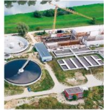
BUDOWA OCZYSZCZALNI ZGODNIE Z PLANEM
