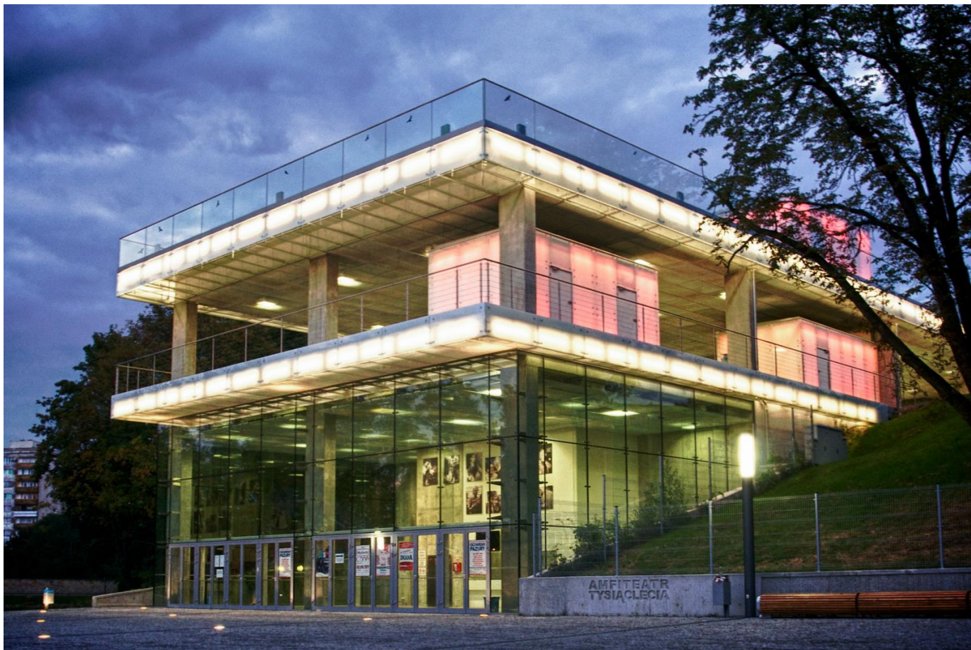
Wejście główne, widok współczesny.
