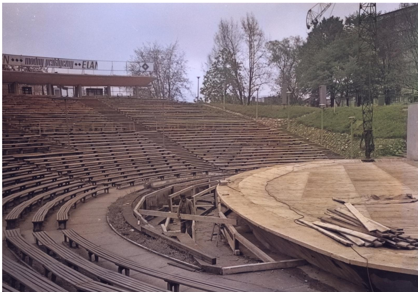
Prace budowlane, fot. Tadeusz Horoszkiewicz
