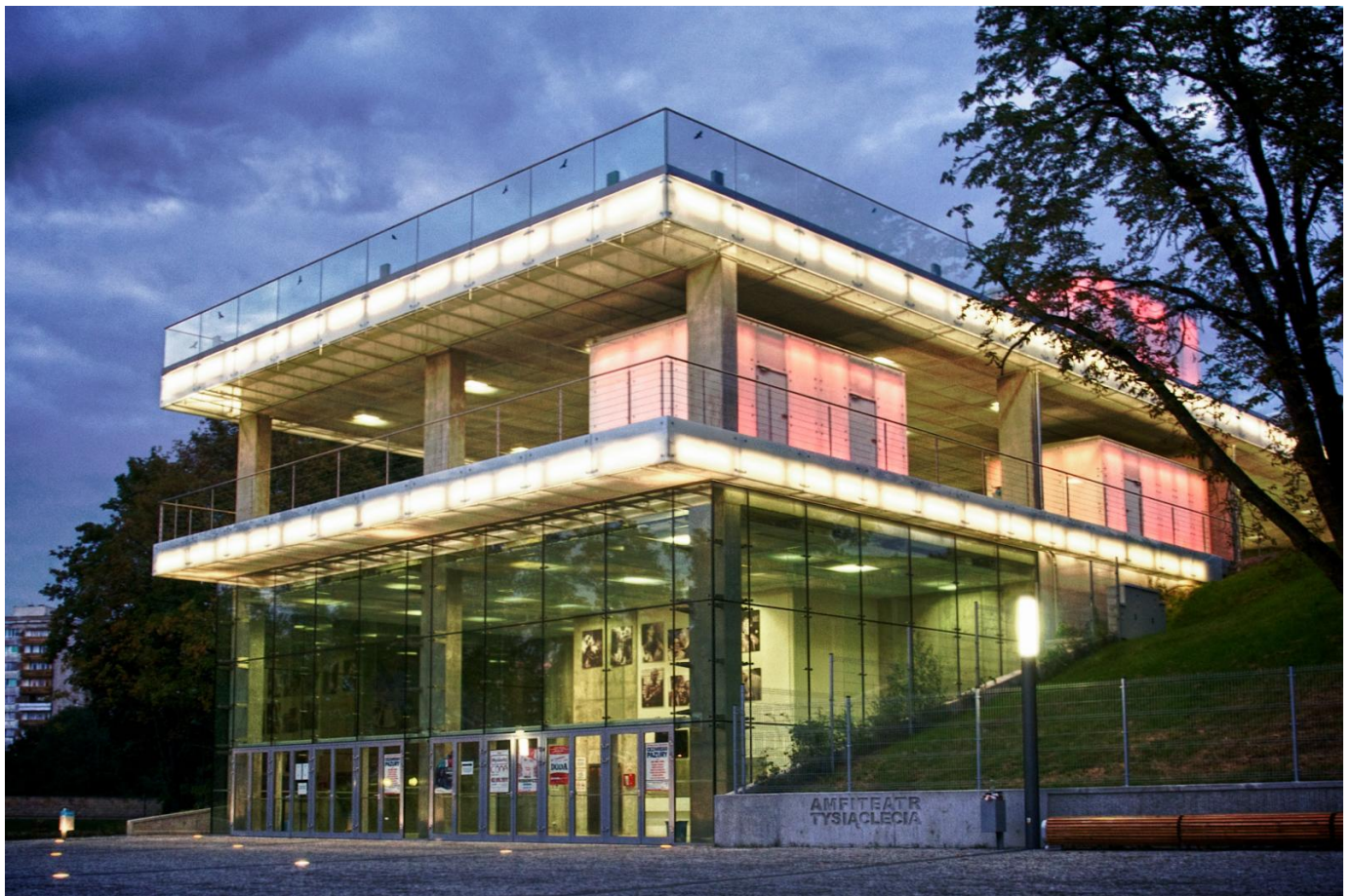
Wejście główne, widok współczesny.
