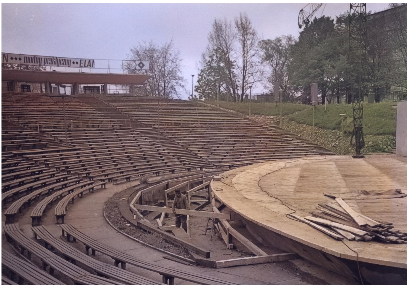
Prace budowlane, fot. Tadeusz Horoszkiewicz
