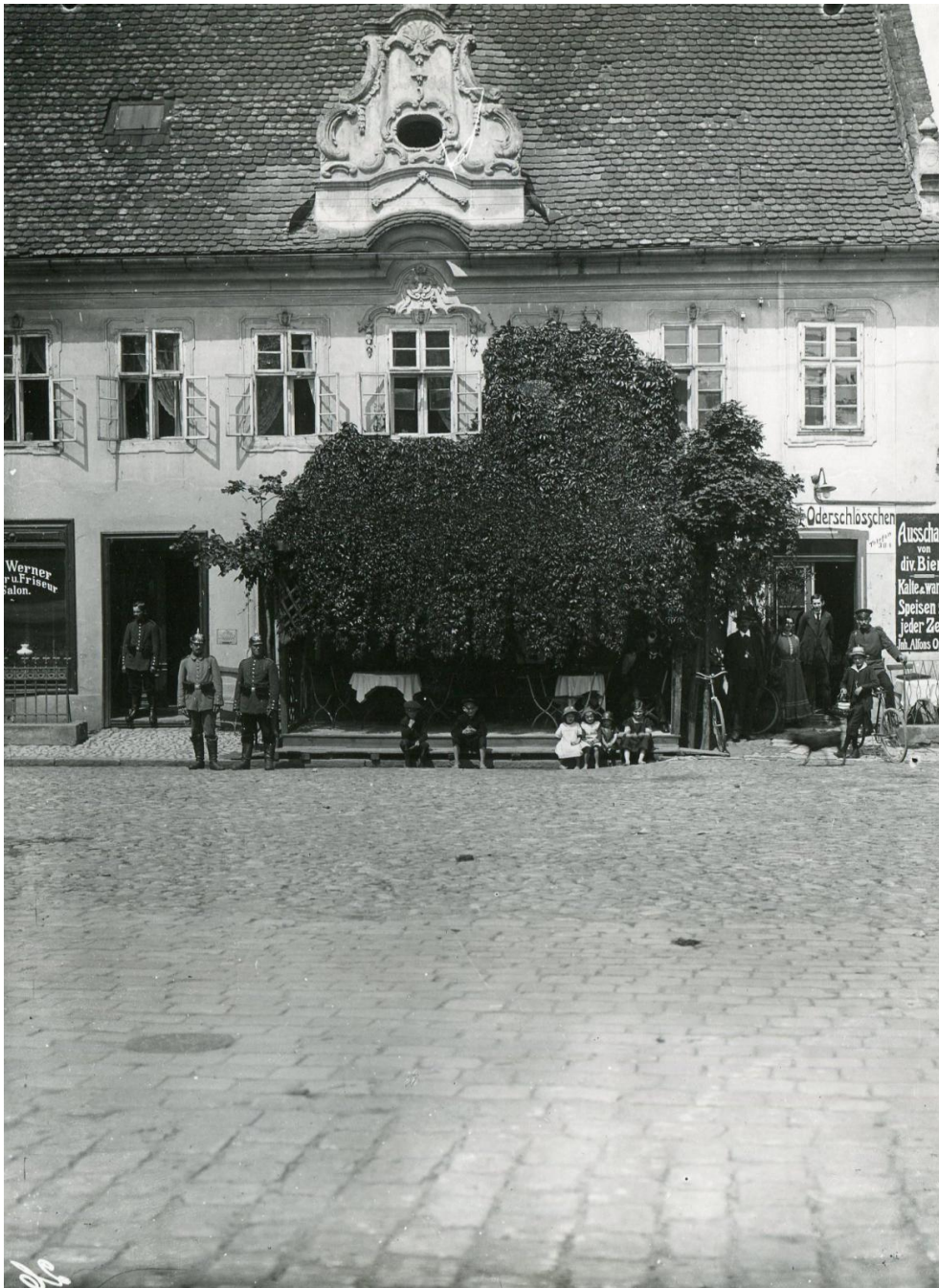
Nieistniejące budynki przy placu J. Piłsudskiego, lata 20. XX wieku
