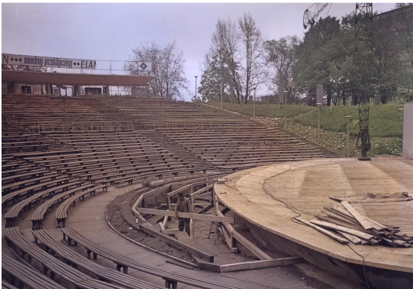
Prace budowlane, fot. Tadeusz Horoszkiewicz
