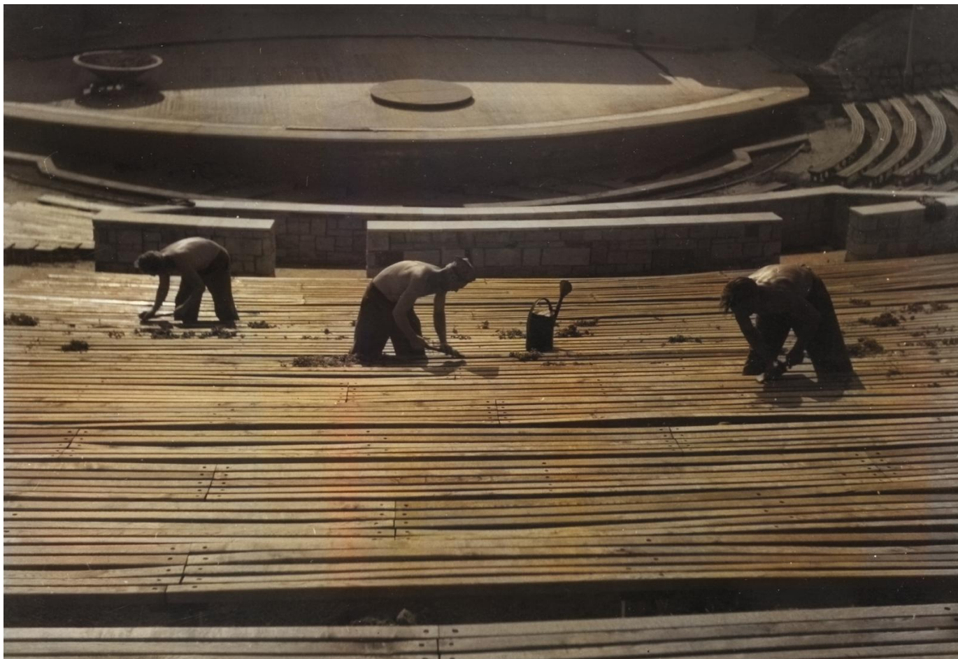
Prace budowlane, fot. Tadeusz Horoszkiewicz
